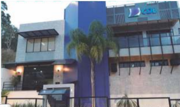
Sede da CDL Barra Mansa localizada no bairro Ano Bom
