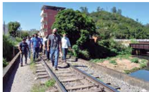
Visita técnica às obras do pátio de manobras.
